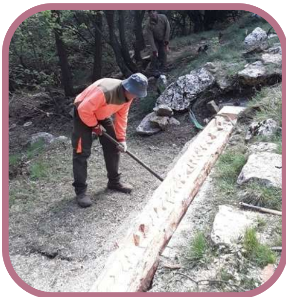
Canvi abeurador de fusta de la Font de la Gatellera. Vallibona
