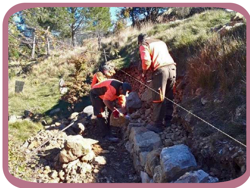
Reparació mur de pedra. Ballestar
