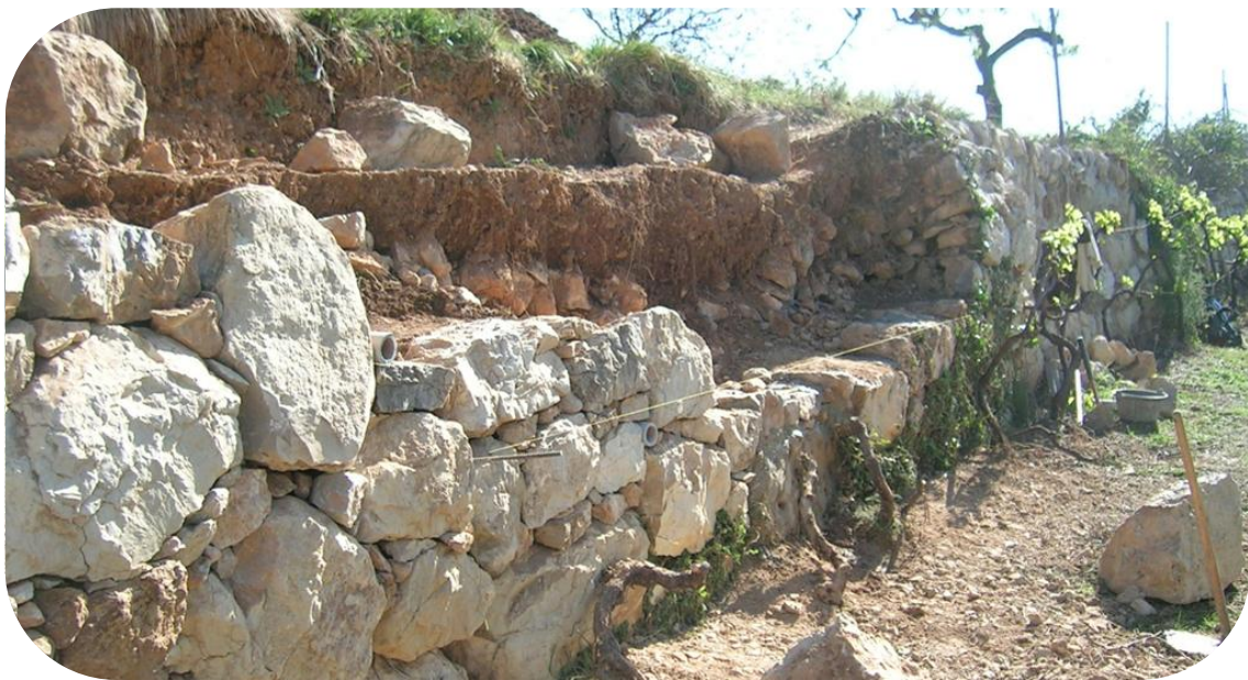
Foto 7: Reparación muro en el camino del Convent.
