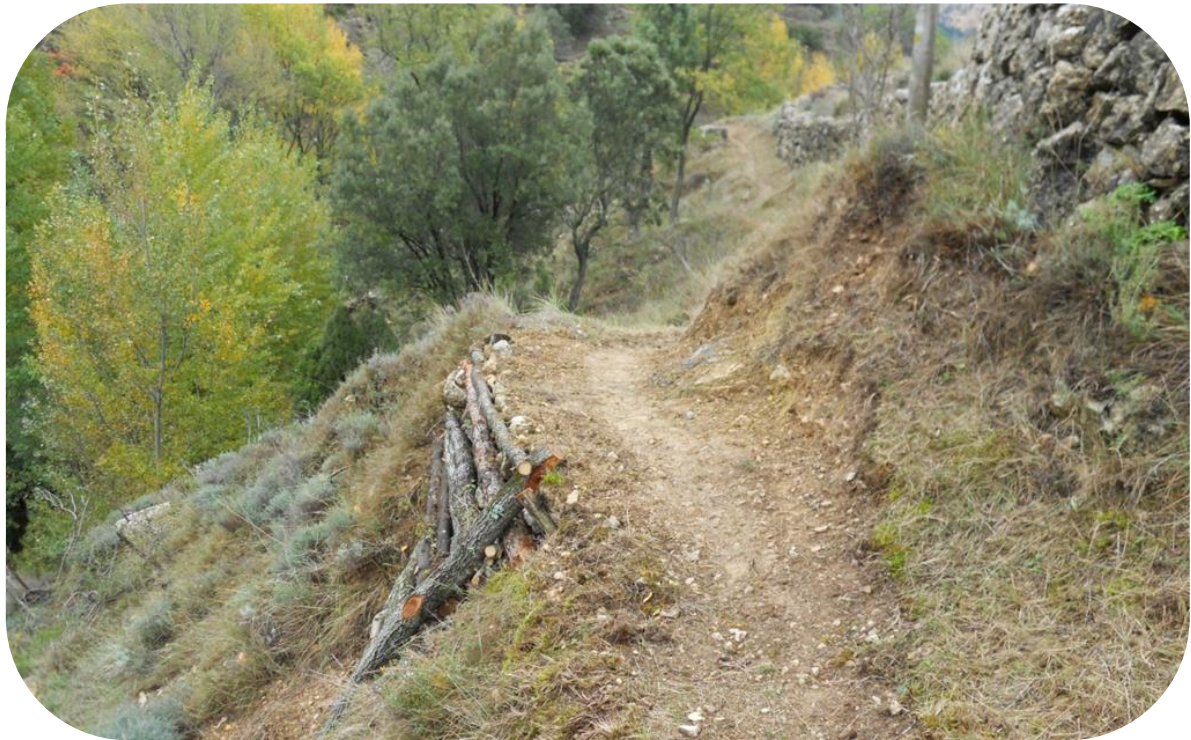
Foto 6: Desbroce y refuerzo camino del Turmell
