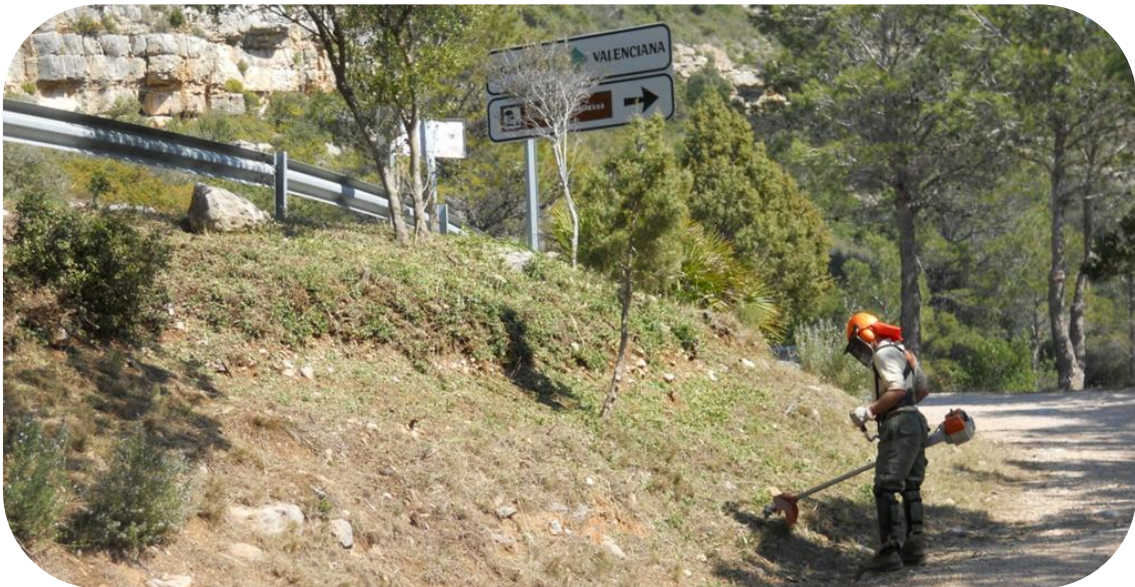
Foto 9: Desbroce área recreativa Ombrías de Benifassà
