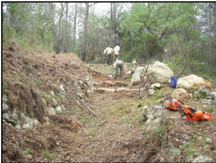
Fotos 33, 34 y 35: Trabajos de desbroce y corrección del firme en el camino de San Domingo (durante). Fuente: Archivo fotográfico del PN de la Tinença de Benifassà.
