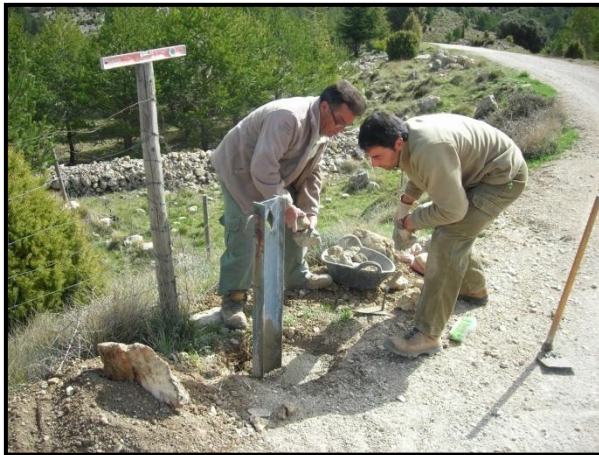
Foto 21: Colocación de la cadena de restricción de acceso. Fuente: Archivo fotográfico del PN de la Tinença de
