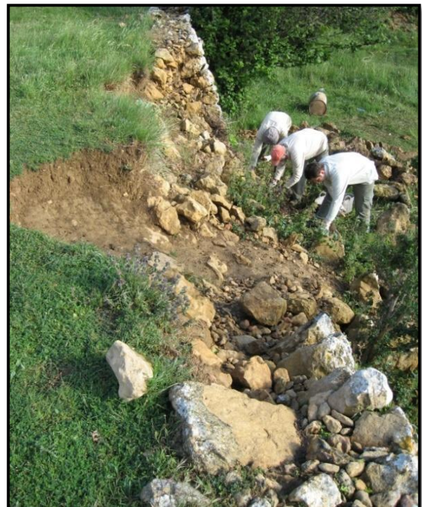
Foto 41: Arreglo de un muro caído en Bel. Fuente: Archivo fotográfico del PN de la Tinença de Benifassà.
