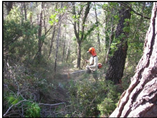
Fotos 33, 34 y 35: Trabajos de desbroce y corrección del firme en el camino de San Domingo (durante). Fuente: Archivo fotográfico del PN de la Tinença de Benifassà.
