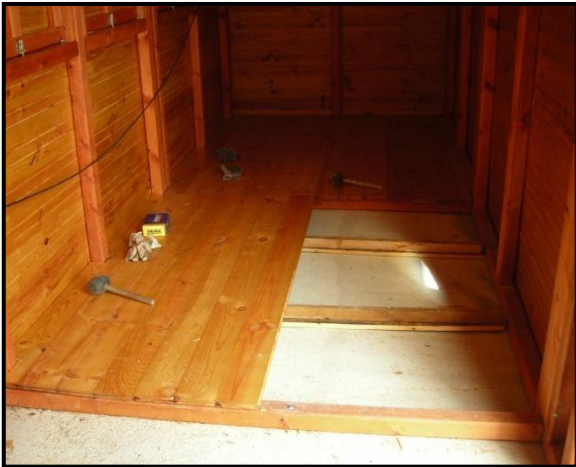
Foto 18: Colocación de la tarima que conforma el suelo.
