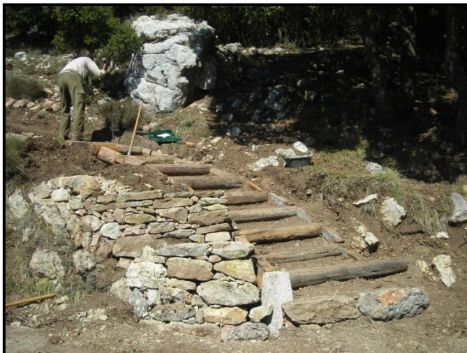
Foto 20: Construcción de murete y escaleras para el inicio de la senda de acceso al observatorio.
