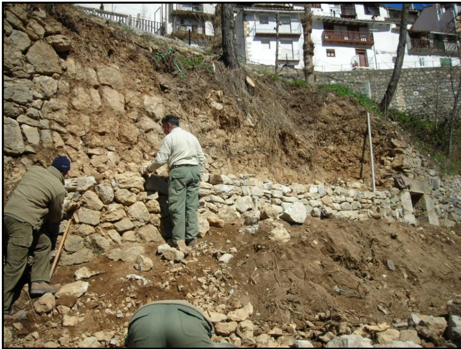
Foto 37: Arreglo de muro en Vallibona tras la eliminación de vegetación invasora ( Pteris , Agave americana ).
