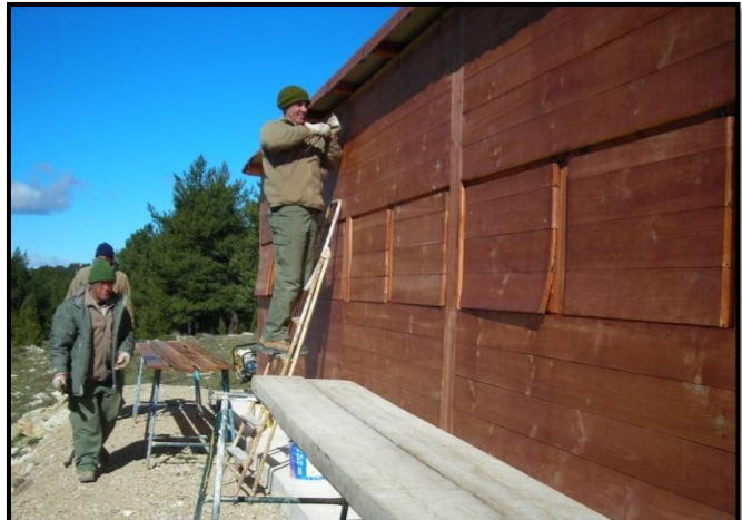
Foto 19: Arreglando el exterior del observatorio.
