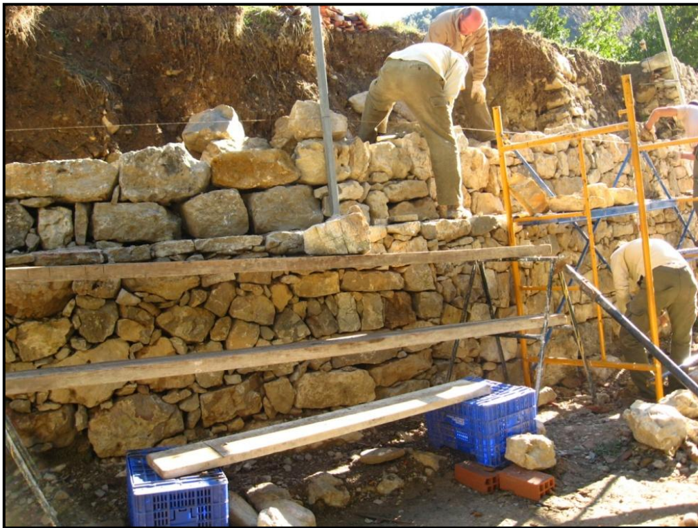
Fotos 44: Construcción de muro de piedra en seco en el Forn del Vidre. Fuente: Archivo fotográfico del PN de la Tinença de Benifassà.
