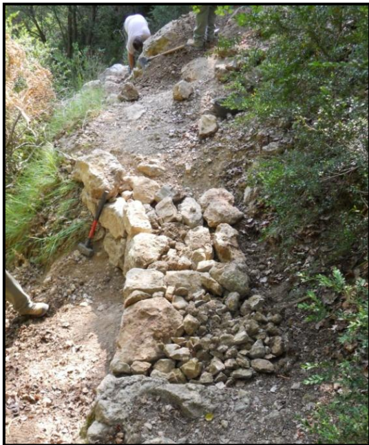
Foto 40: Fijación del firme de la senda en las cercanías del Salt de Robert.
