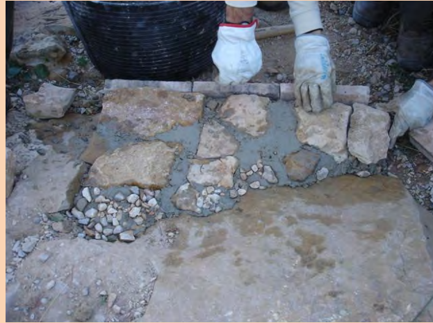
Figura 48: Construcción de escalones en la Dunta del Cavall (Benidorm) Fuente: Archivo fotográfico del Parc Natural de la Serra Gelada
