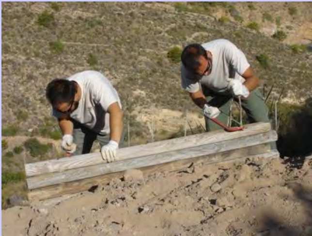
Figura 52: Construcción de vallado de contención en talud de la ruta del Faro del Albir (L'Alfàs del Pi) Fuente: Archivo fotográfico del Parc Natural de la Serra Gelada
