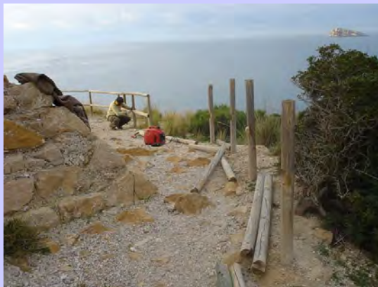
Figura 50: Construcción de vallado de seguridad en la Punta del Cavall (Benidorm)
