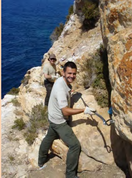
Figura 46: Instalación de pasamanos de seguridad para censos de aves en la Isla de Benidorm (Benidorm)
