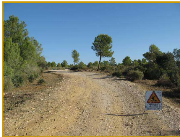
DESBROCE ACCESO PN
