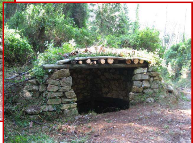
ARREGLO TECHUMBRE HORNO DE CAL EN ITINERARIO A POLPIS
