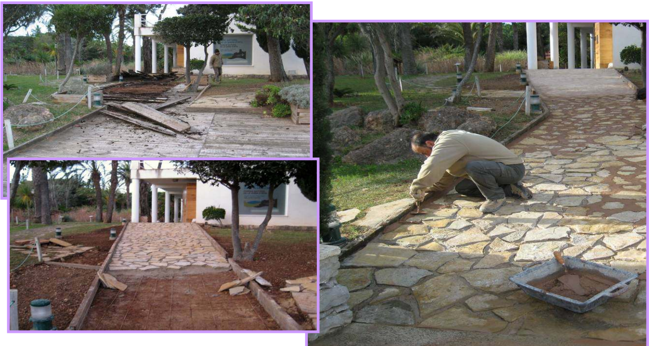
CONSTRUCCIÓN NUEVA RAMPA ACCESO CENTRO DEL PARQUE NATURAL
