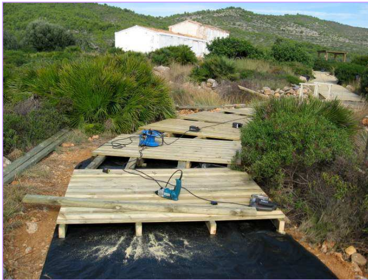
COLOCACIÓN DE LA PASARELA DE MADERA EN EL ITINERARIO DEL PEBRET
