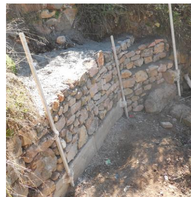
Foto 54. Construcción de muros de mampostería.
