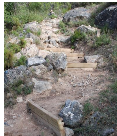
Foto 48. Escalones en la senda de acceso al castillo de Almonecir.
