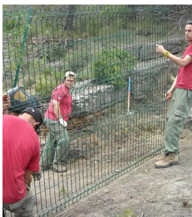
Foto 29. Vallado de la entrada de la cueva de l'Onder.
