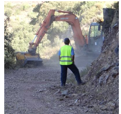
Foto 11. Trabajos en pistas.
