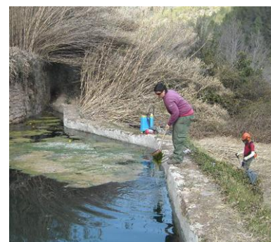
Foto 31. Mantenimiento de la balsa de Fosques.
