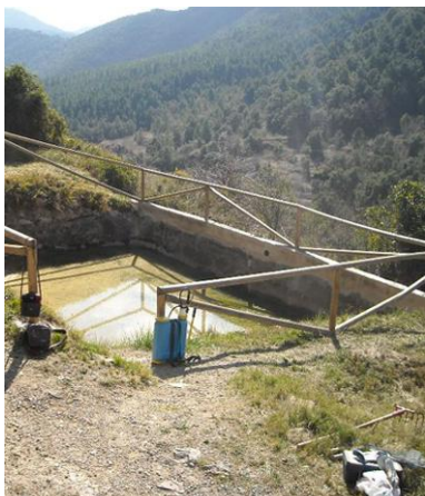
Foto 32. Mantenimiento de la balsa de la Solana.
