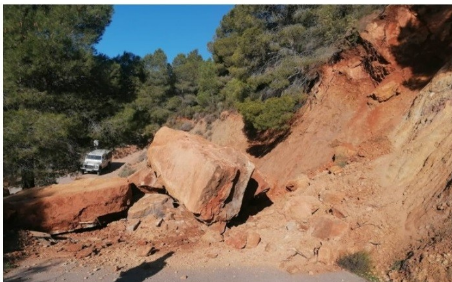
Desprendimiento que ha causado el corte del camino. / LP
