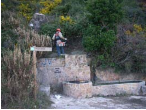
Font del Poll, Serra. Desbroce y arreglo de la fuente.
