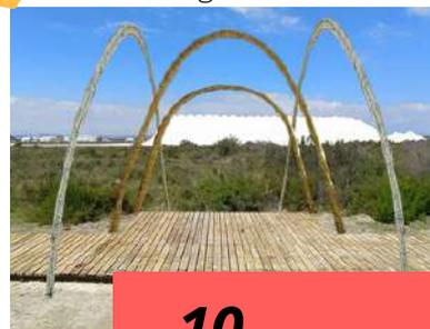
Así que se construyó la plataforma base de madera y se empezaron a colocar los arcos de caña.
