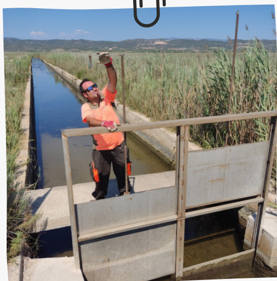
Comportes de la Gola del Trenc
