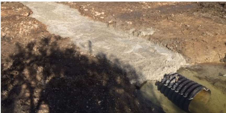
Imatge: Treballs de connexió de séquies -JTC-
