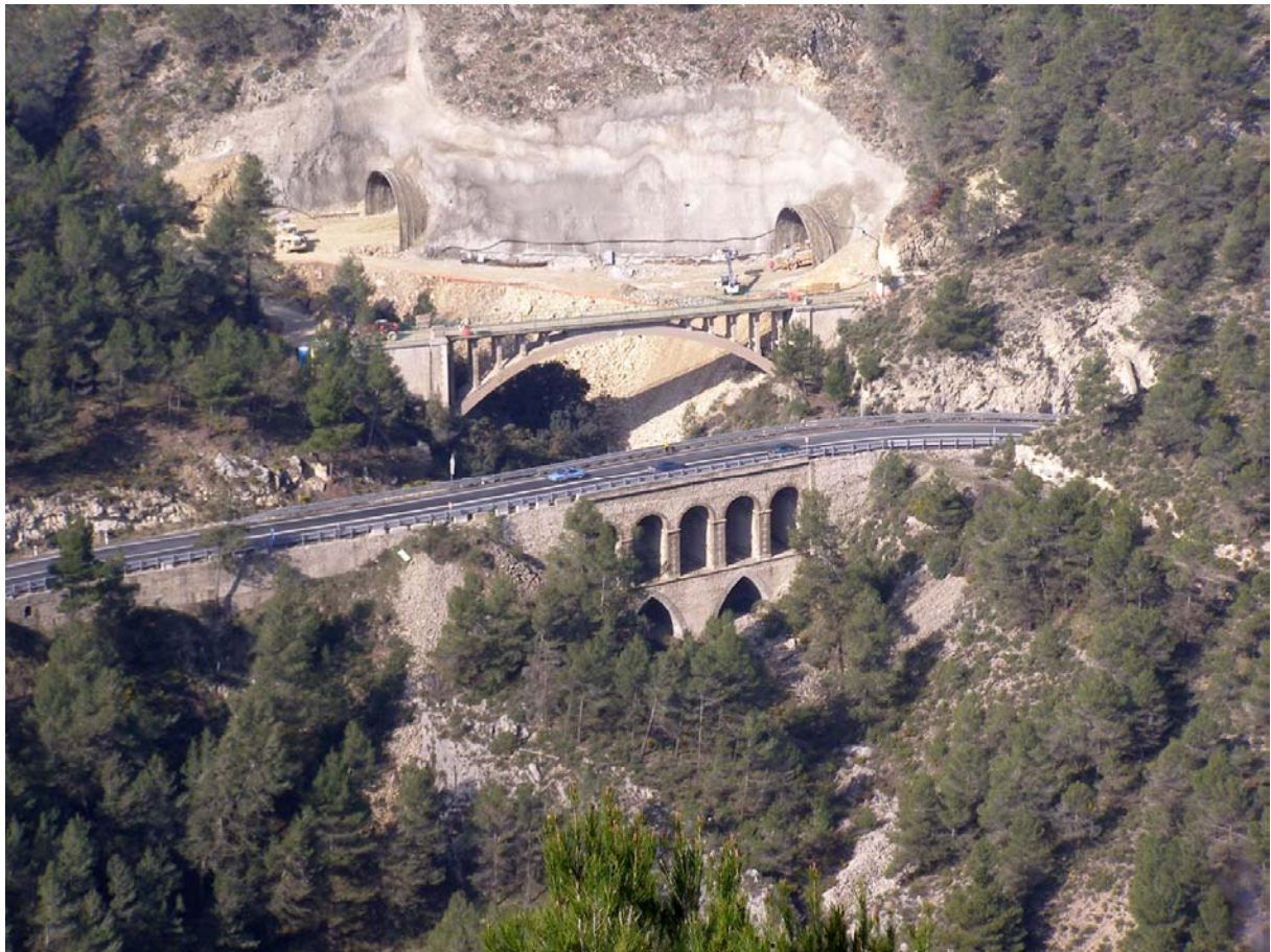
Obras de la boca sur del tunel de la autovia A-36 desde la cima del Puig. Foto: Archivo Parque Natural.
