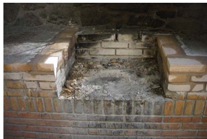
Reparación de los paellers del área recreativa de San Antonio. Fotos: Archivos Parque Natural.
