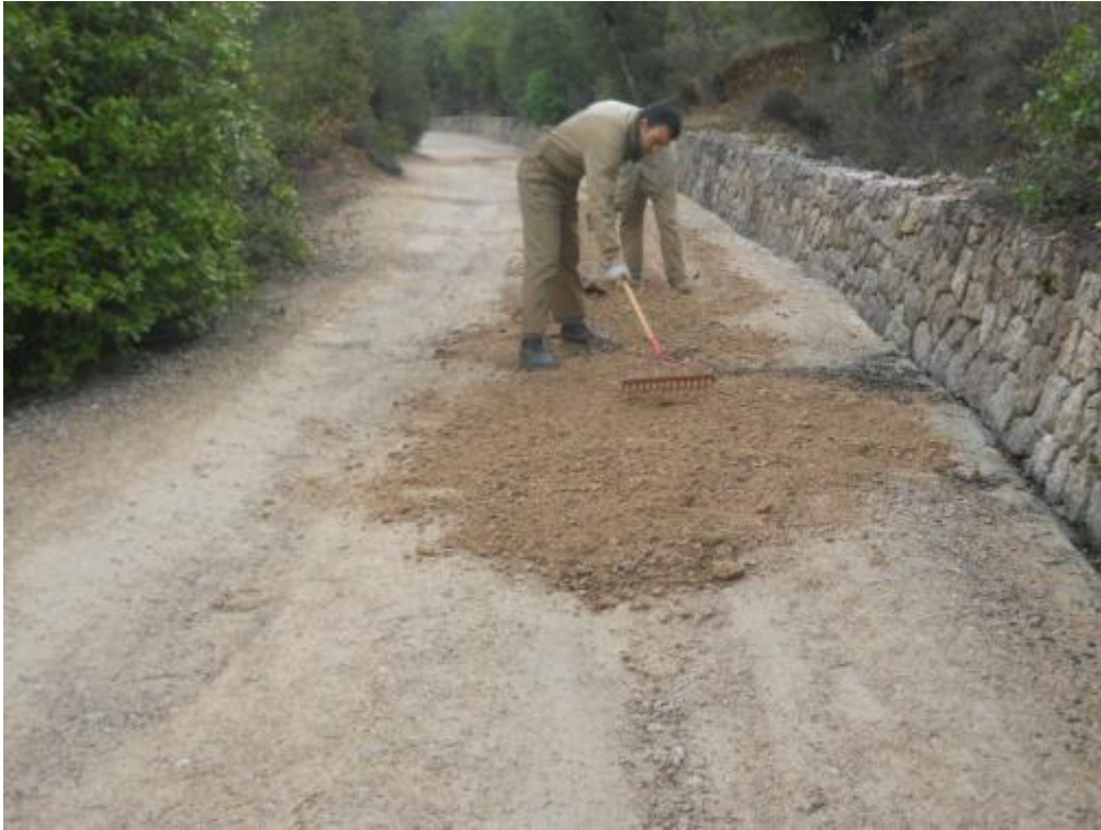
Treballs de restauració de la pista al Menejador. Font: Parc Natural de la Font Roja
