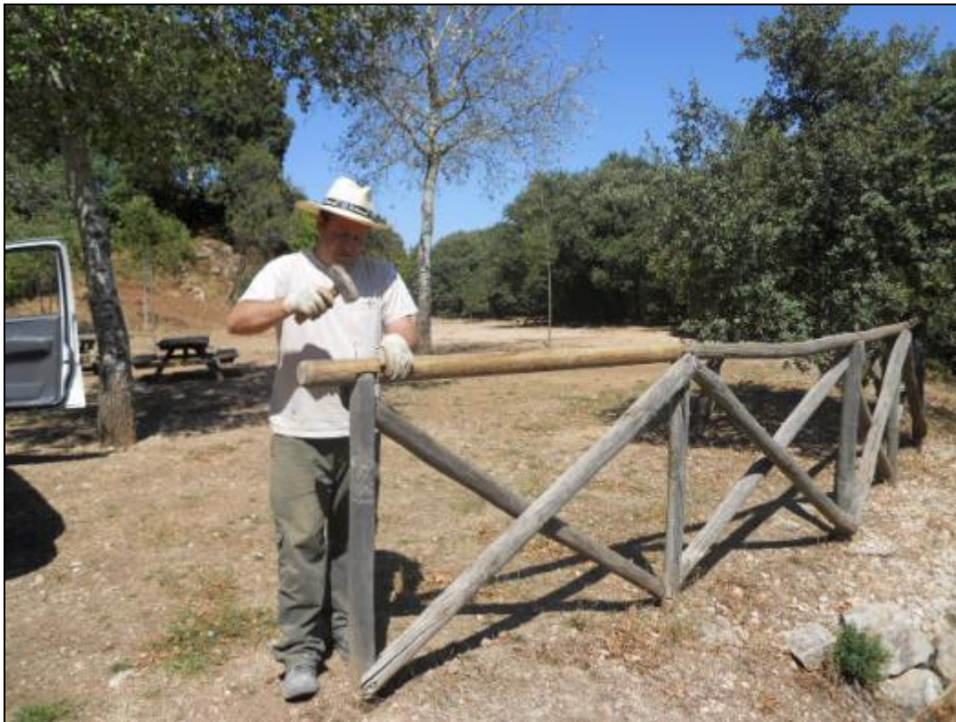
Restauració de barana en la zona d'acampada. Font: Parc Natural de la Font Roja.
