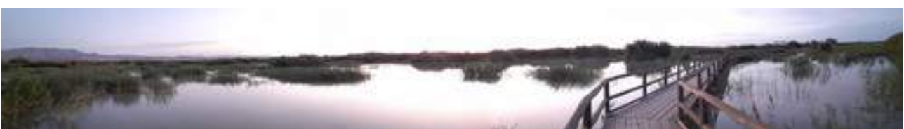
Pasarela "Finca El Rincón"
