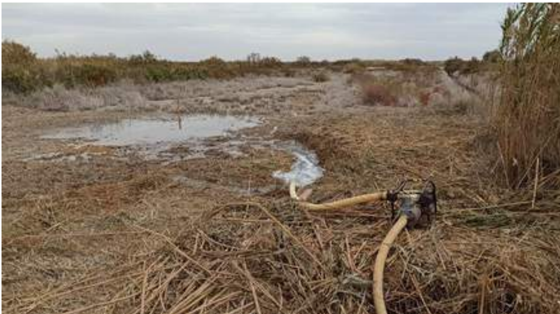
Inundación de la parcela mediante motobomba
