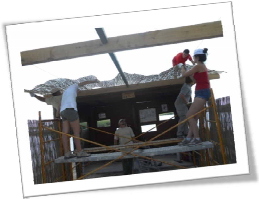
ILUSTRACIÓN 39 INSTALACIÓN DE SOMBRAJE EN EL OBSERVATORIO VOLCAM
