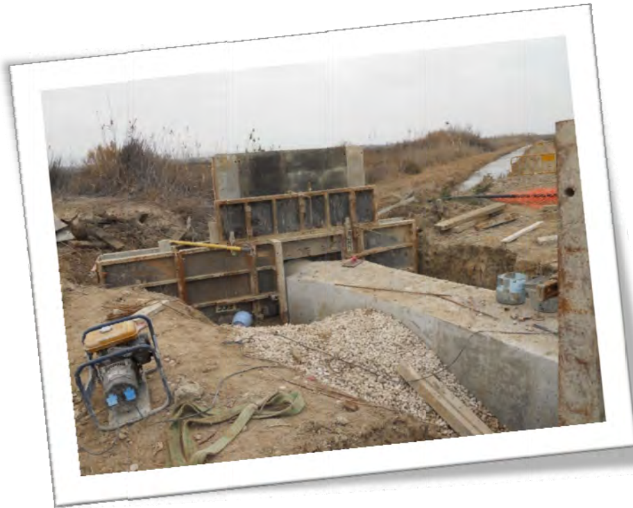
ILUSTRACIÓN 10 OBRAS EN LA FINCA BALSERONES
