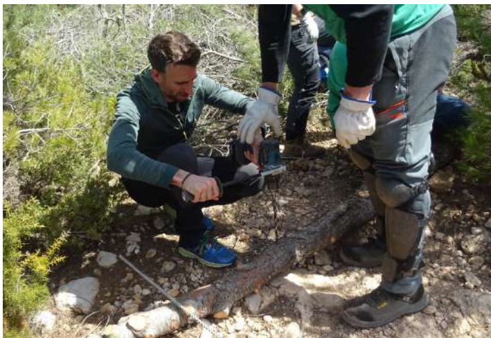
Instal·lació d'obstacles amb varetes corrugades sobre roca en la senda de La Vereda (Chera)
