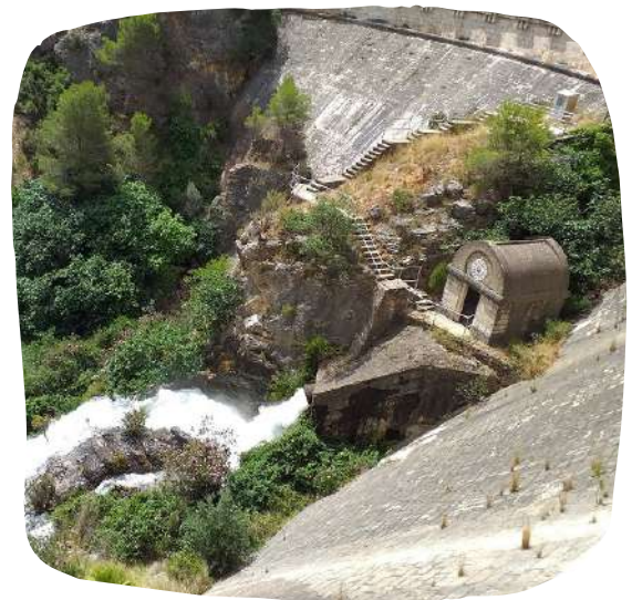
Caseta de la bomba nº 3
