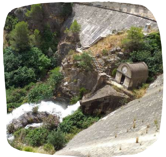
Caseta de la bomba nº 3
