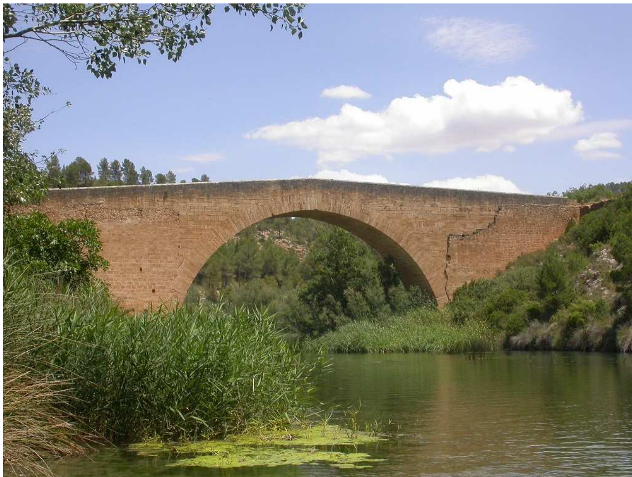
Puente de Vadocañas (Venta del Moro)
