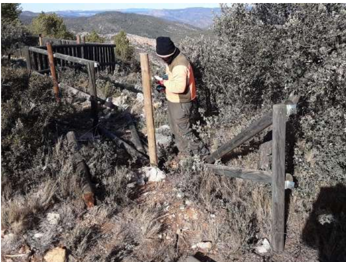
Reparación de vallas en el mirador de Pera
