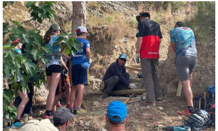
Colocación de travesaños de madera a modo de escalones en la senda
