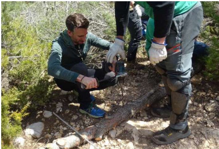
Instalación de obstáculos con varillas corrugadas sobre roca en el sendero de La Vereda (Chera)
