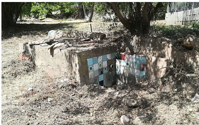
Fuente del Ramblizo antes de su restauración
